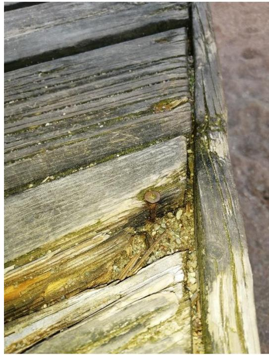
*Aus dem Holz des Parcours schauen bereits die Schrauben heraus, sodass hier aus unserer Sicht ein Verletzungsrisiko besteht oder die Kleidung beschädigt werden könnte.*
