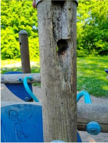
Die Holzpfiler, welche die Grundstruktur bilden, sind teilweise gesplittert und stellen somit eine Verletzungsgefahr da. Es sind auch einige Löcher in diesen vorhanden.
