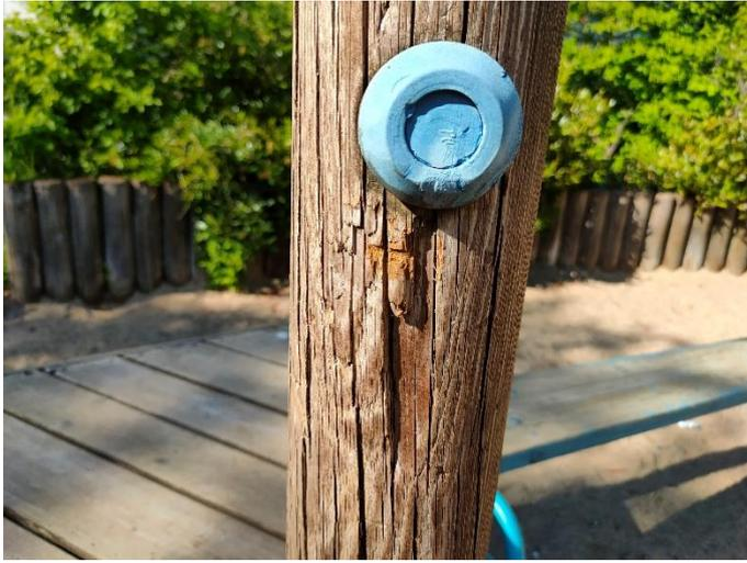
Die Holzpfähle aus denen der Parkour besteht splittert. Somit besteht Verletzungsgefahr
